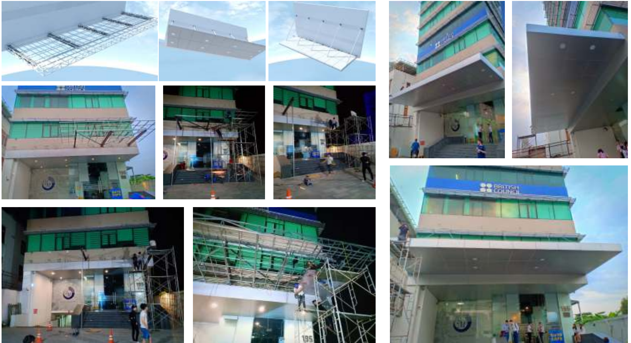
Mái đón mặt tiền tòa nhà Dream Plex 195 Điện Biên Phủ
